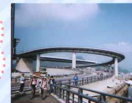
大橋を渡り下から見る ハイヤ大橋
