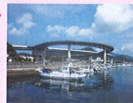
大橋を渡り 下から見るハイヤ大橋
