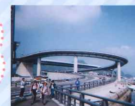
大橋を渡り下から見る ハイヤ大橋
